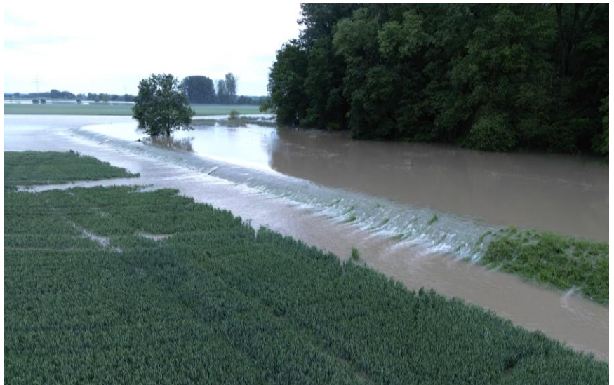
Der überspülte Damm oberhalb der Glöttbrücke, Sonntag, 02.06.2024, 21:00 Uhr
