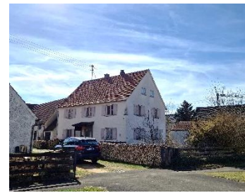
Leerstehende Hofstelle in Unter- glauheim (Quelle: Baader Konzept)
